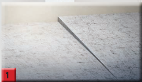
1 vytvorenie 2 % spádovej časti
