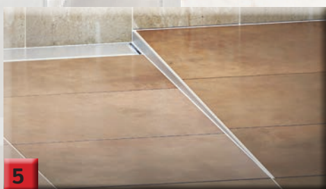
5 škárovanie, silikónovanie dlažby
