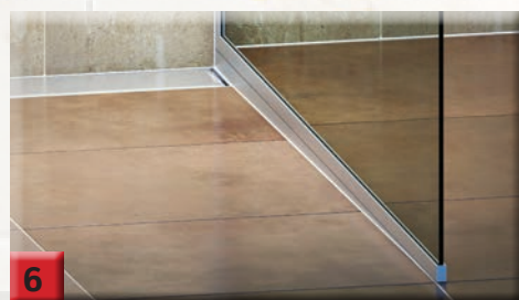
6 osadenie U profilu na sklo a sklenenej tabule
