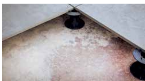
POKLÁDKA NIVELIZAČNÝM SYSTÉMOM
