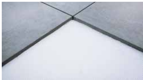
POKLÁDKA DO CEMENTOVÉHO LÔŽKA
