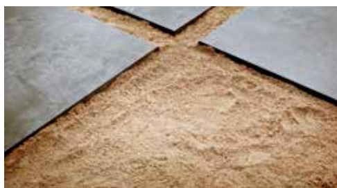
POKLÁDKA DO PIESKOVÉHO LÔŽKA
