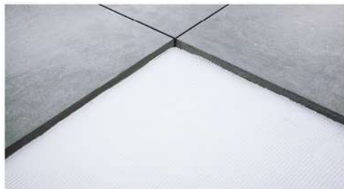
POKLÁDKA DO CEMENTOVÉHO LÔŽKA
