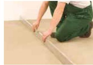
Začíname od jeho dokladného očistenia. Nevyhnutne skontrolujeme úroveň podlahy, jej nosnosť a vlhkosť. Ďalšou etapou je naniesanie penetračného náteru. Ak sa na povrchu, na ktorý chceme klásiť dlaždičku, vyskytujú nerovnosti, môžeme ich zarovnať pomocou nivelačnej zmesi. Ak sú nerovnosti výrazné, zvolíme vhodný technologický postup na ich odstránenie.
