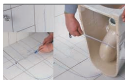
Označenie otvorov pre uchytenie misy
