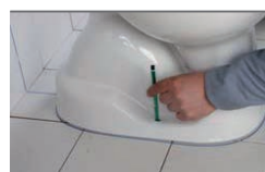
Označenie otvorov pre uchytenie k podlahe
