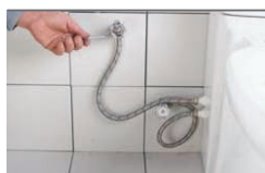
Montáž hadičiek – k ventilom/batérii
