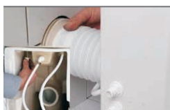
Napojenie odpadu
