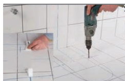
Vyvrtanie otvorov a montáž držiakov (L)
