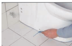
Rozmeranie otvorov pre uchytenie misy
