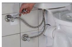
Montáž hadičiek – k ventilom/batérii
