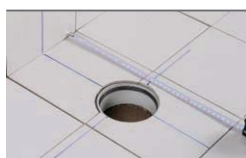
Zameranie a vyznačenie stredovej osi
