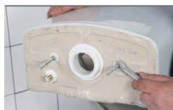
Montáž splachovača
