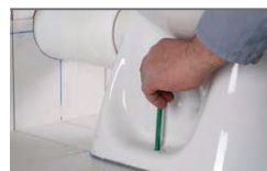
Označenie otvorov pre uchytenie k podlahe
